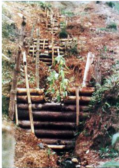
Figura 7.10. Trinchos para control de erosión en cárcavas
