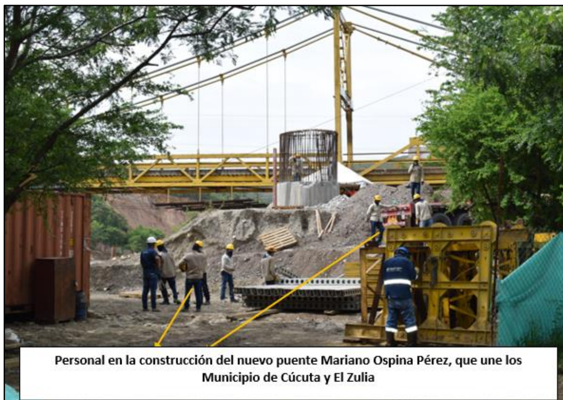
Figura 19. Identificación de la construcción del nuevo puente Mariano Ospina Pérez.
