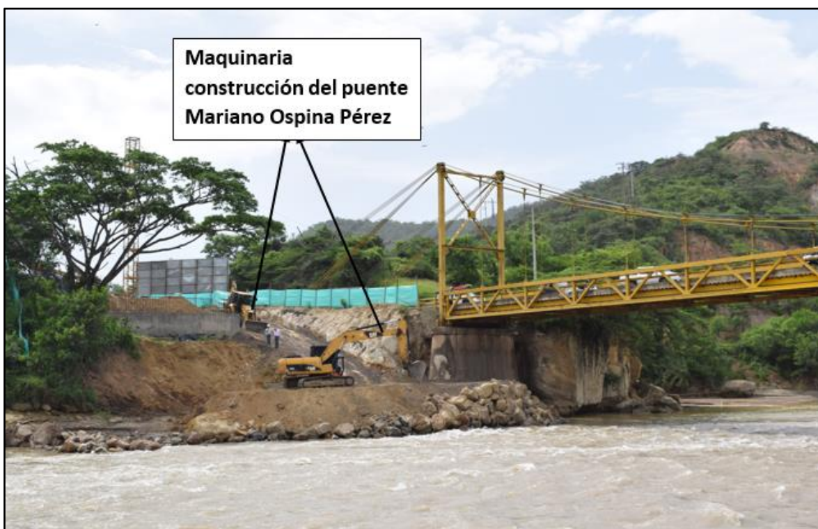
Figura 16. Trabajos de obra con retroexcavadoras y maquinaria pesada en el ID 11.
