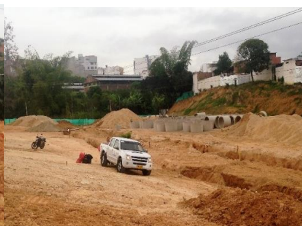
MOVIMIENTO DE TIERRAS E INSTALACIÓN TUBERÍA PARA ALCANTARILLADO
