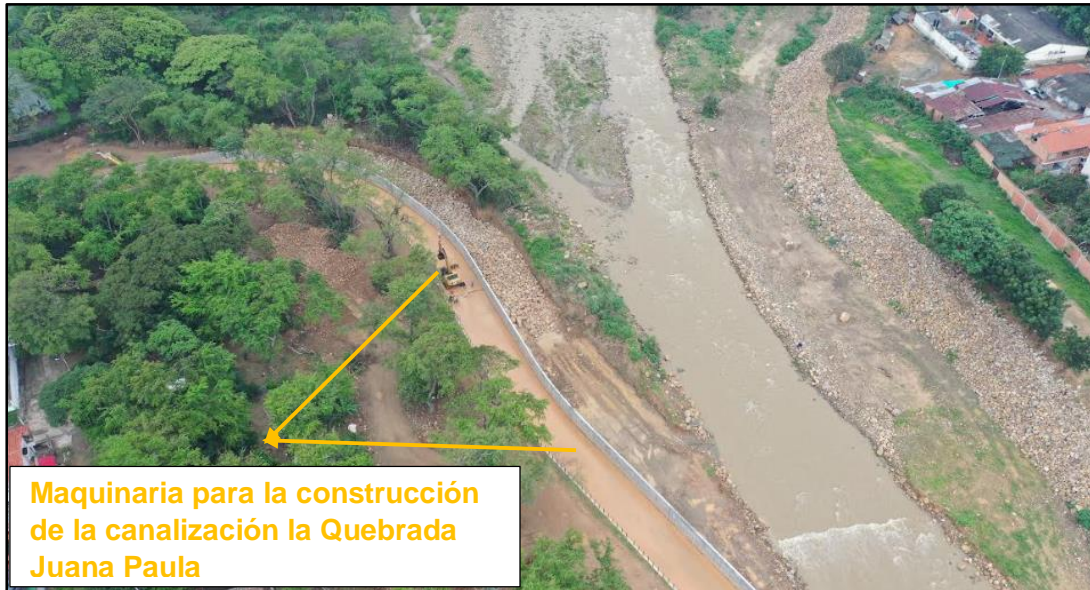
Figura 26. Presencia de maquinaria pesada.
