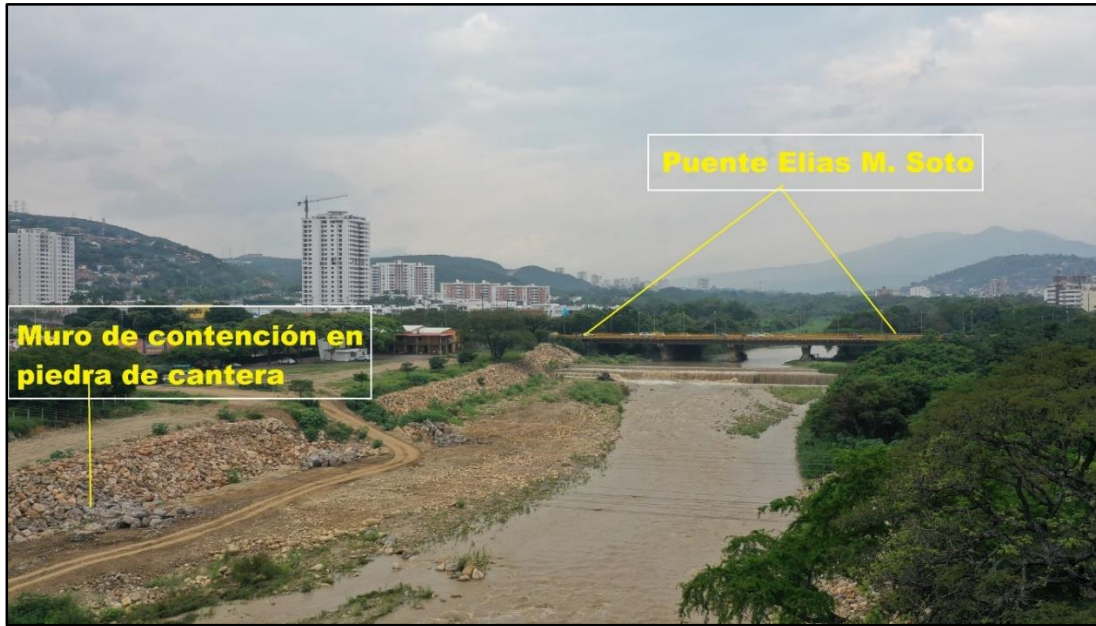
Figura 27. Muro de contención en piedra de cantera por la ribera del río.
