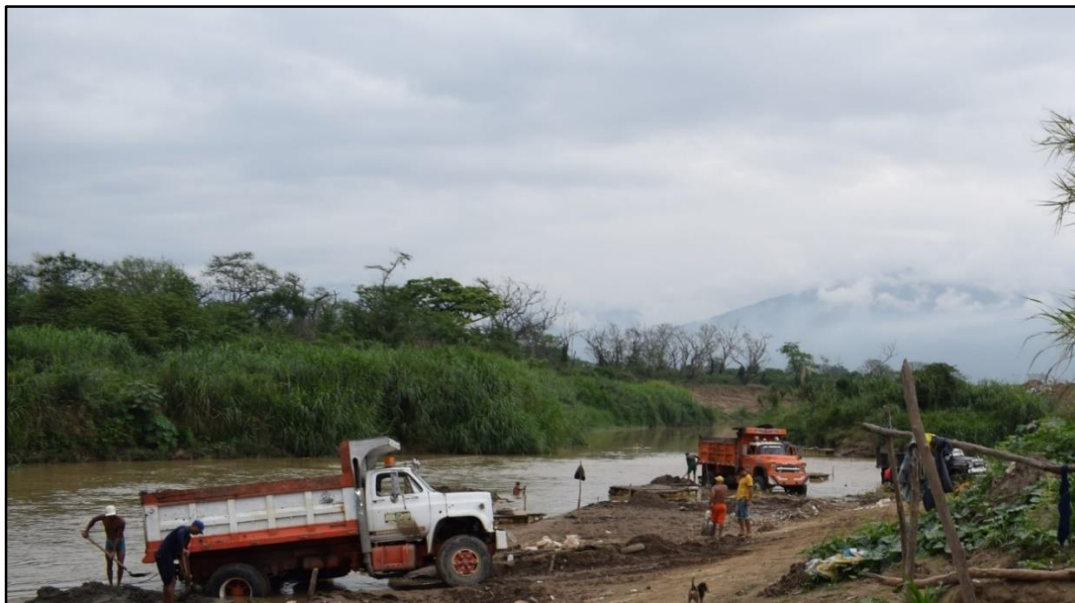
Figura 33. Trabajos de extracción de material de arrastre.
