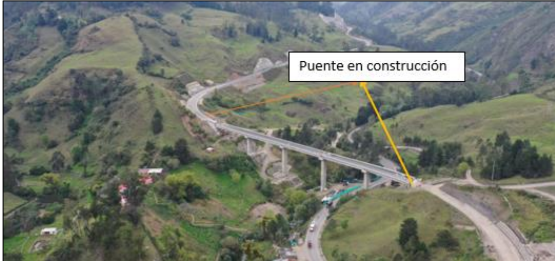
Figura 6. Puente en construcción entre la vía Cúcuta-pamplona.
