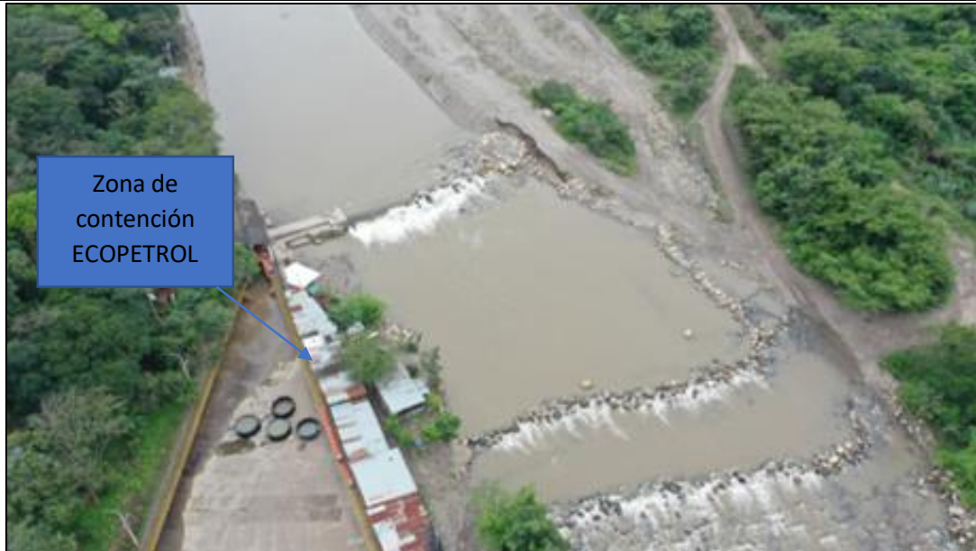
Figura 19. Zona de trabajo actividades de contención ECOPETROL.
