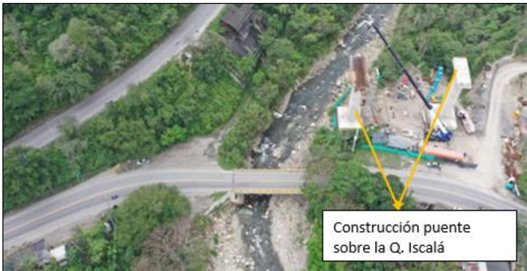
Figura 18. Construcción puente sobre el ID.
