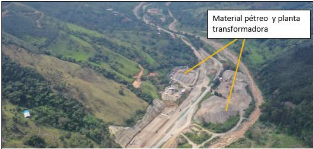
Figura 11. Trabajos de materiales pétreo y planta transformadora.
