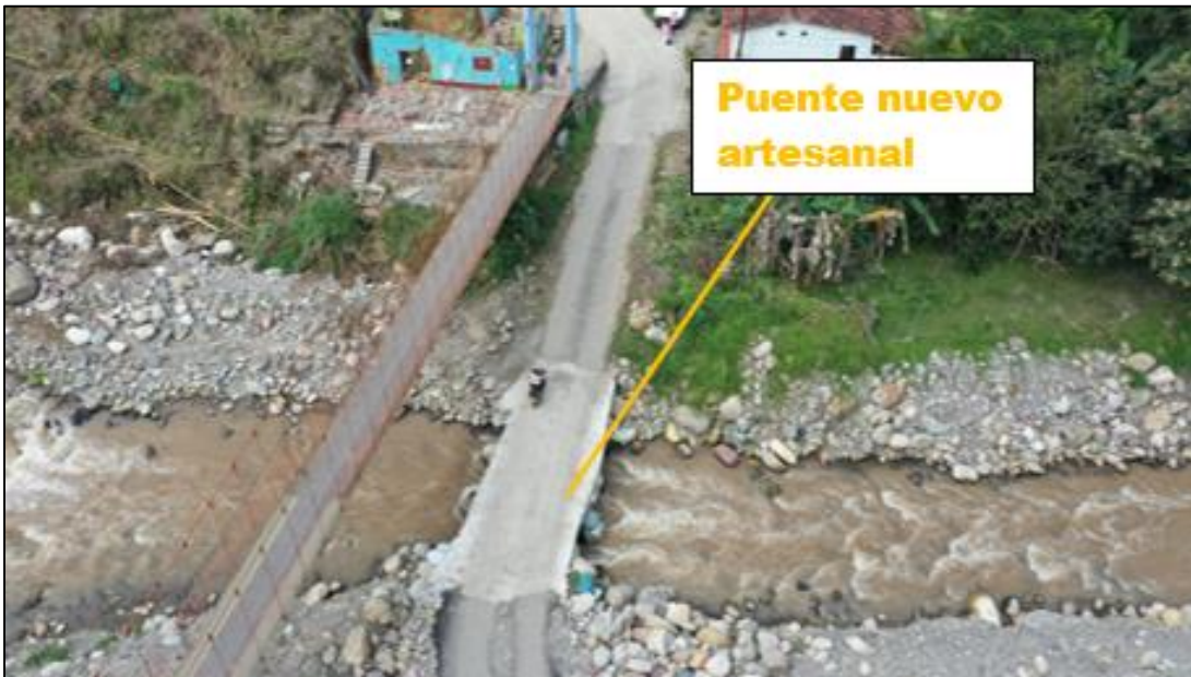
Figura 10. Construcción de un puente artesanal.
