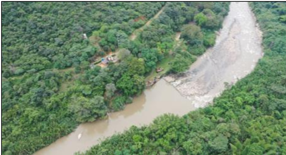
Figura 24. Identificación acueducto Aguas Kpital aguas abajo del ID.
