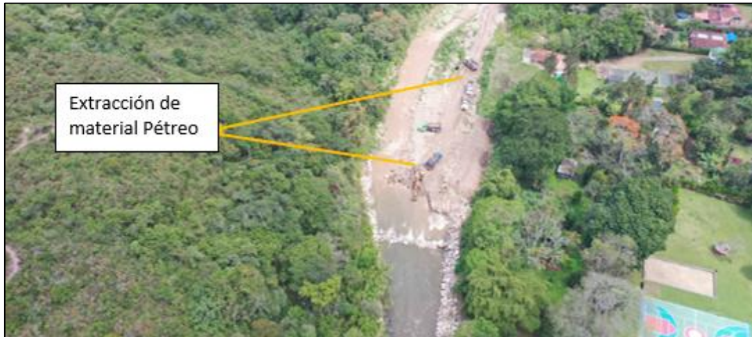
Figura 13. Punto detrás del centro recreativo guayabales, trabajos de extracción de material.
