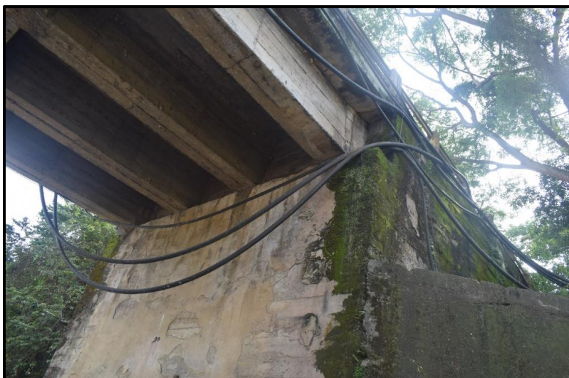
Figura 23. Captación de agua del río en el ID 16.
