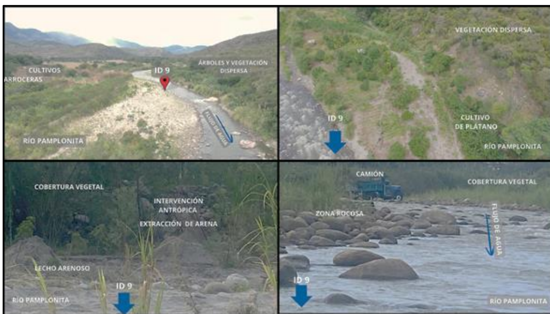
Figura 10 ID9. Bocatoma Acueducto Cúcuta –El Pórtico.
