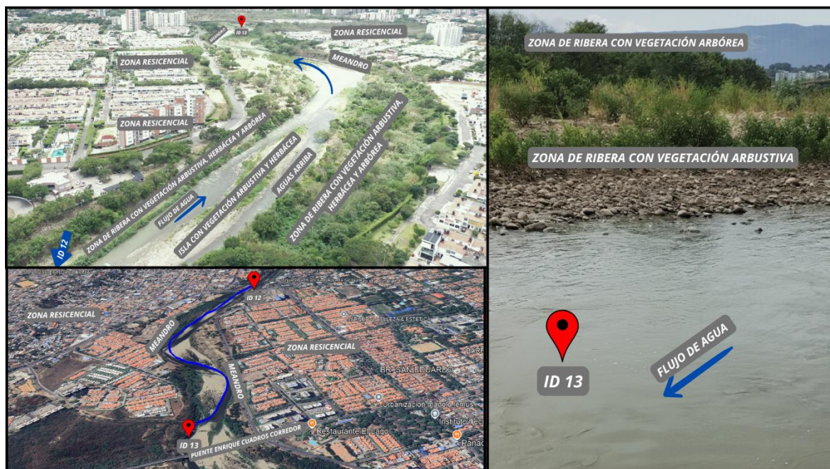
Figura 14 ID13. Puente Enrique Cuadros Corredor – La Gazapa.
