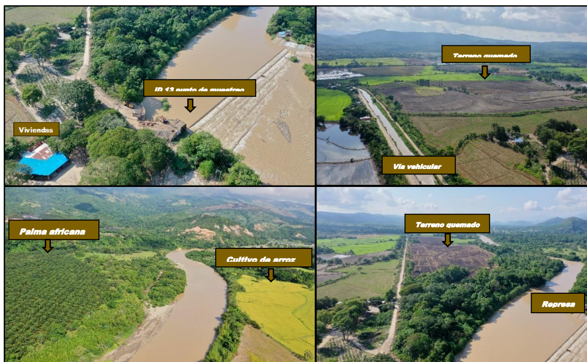
Figura 17. ID 13. Antes de La Captación Represa Distrito de Riego
